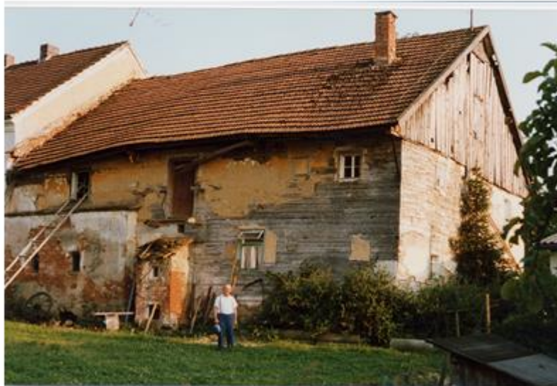
2. Bild Das Hofbauergut – vor dem Abriss
