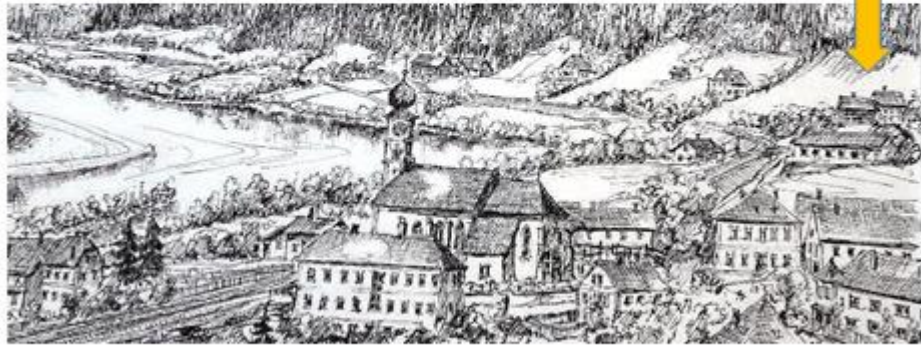
1. Bild Das Hofbauergut – vor dem Abriss
